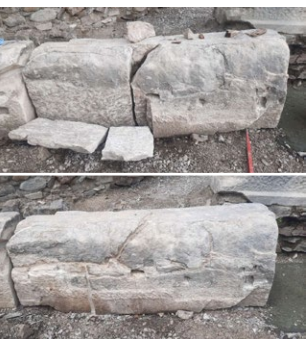
In-situ-Restaurierung des östlichsten Blockes der Stufe. Oben der Zustand im Zuge der Reinigung der Bruchflächen, unten der Block nach der Neuverklebung der Bruchstücke
