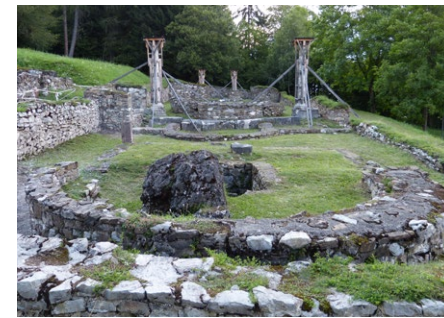
Ansicht der „Bischofskirche“ vor Beginn der Restaurierungsarbeiten im Jahr 2017
